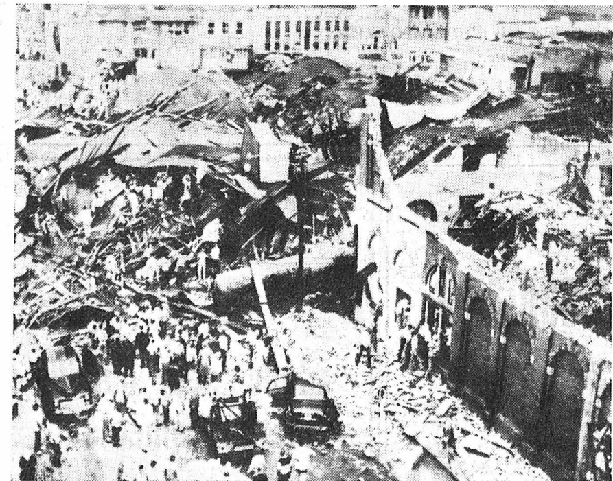
Le terrible ouragan qui a ravagé, au Texas, la ville de Waco, a fait s'écrouler d'innombrables habitations causant la mort de près de 120 personnes. Ci-dessus une photo qui donne une idée impressionnante des ravages causés par la catastrophe.
