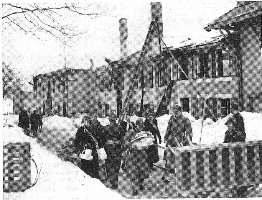
Un incendie a détruit quatre maisons contiguës au lieu dit Bas de Chenit, dans la Vallée de Joux. Voici les ruines des bâtiments que six familles ont dû abandonner. Alors que le mobilier restait dans les flammes, le bétail fut sauvé à grand'peine.
