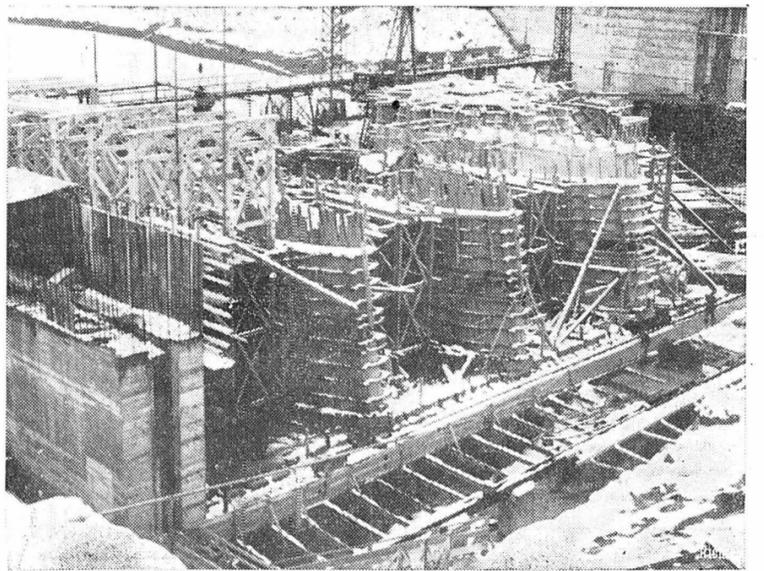
La construction de la halle aux machines du barrage avance à grands pas. C'est dans un bloc de béton armé de 110 m. de long et de 60 m. de large que seront creusées les conduites d'eau alimentant les turbines. Les travaux ont commencé il y a deux ans.
