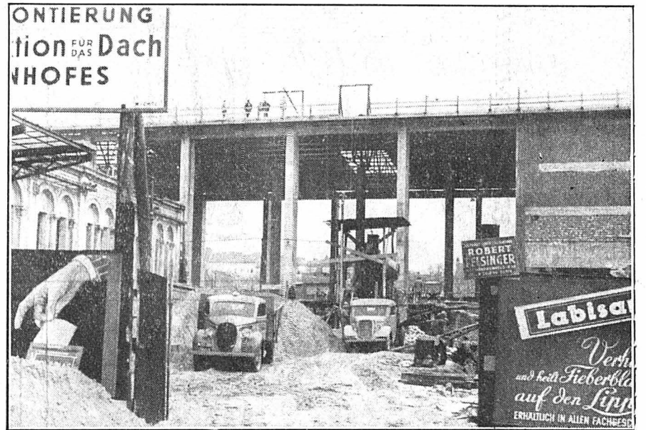
Le chantier de reconstruction de la Gare de l'Ouest, à Vienne.
