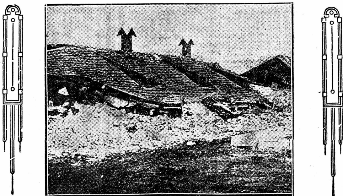
Instantané montrant les maisons écroulées et l'amoncellement des ruines dans un village macédonien.
