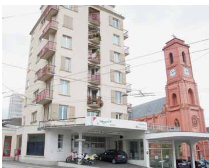
La banque Raiffeisen du Vignoble occupera le rez-de-chaussée de l'ex-tour Firestone. Le chantier devrait débuter en mai. ARCHIVES
