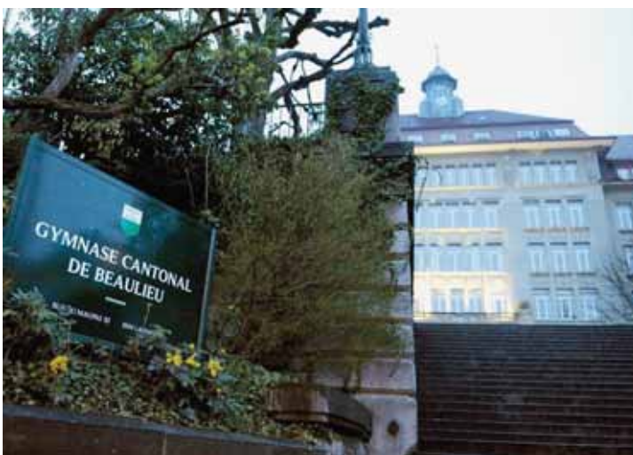
En 2008, le Gymnase de Beaulieu a frôlé le drame. Un jeune homme armé et transportant des munitions a pu être neutralisé. KEYSTONE
