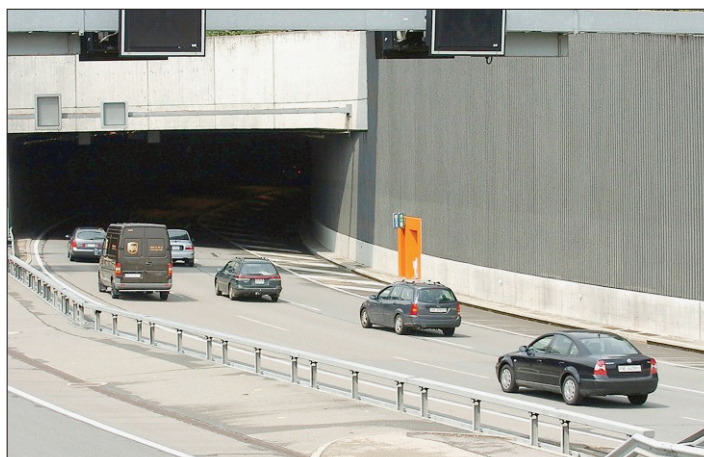
TUNNELS DE LA N5 Les améliorations porteront notamment sur la signalisation et la ventilation. (ARCHIVES RICHARD LEUENBERGER)
