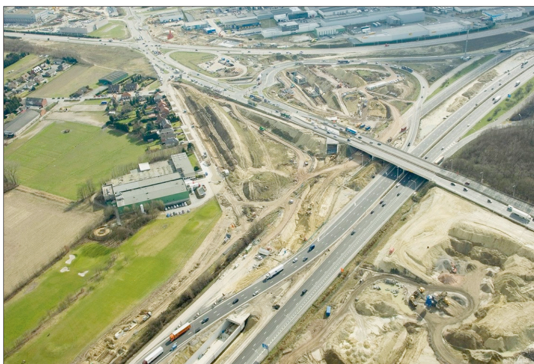
BELGIQUE Cette vue aérienne donne une idée de l'ampleur des travaux menés actuellement aux abords de l'aéroport de Bruxelles. Un tronçon de la nouvelle ligne de train longera l'autoroute.
