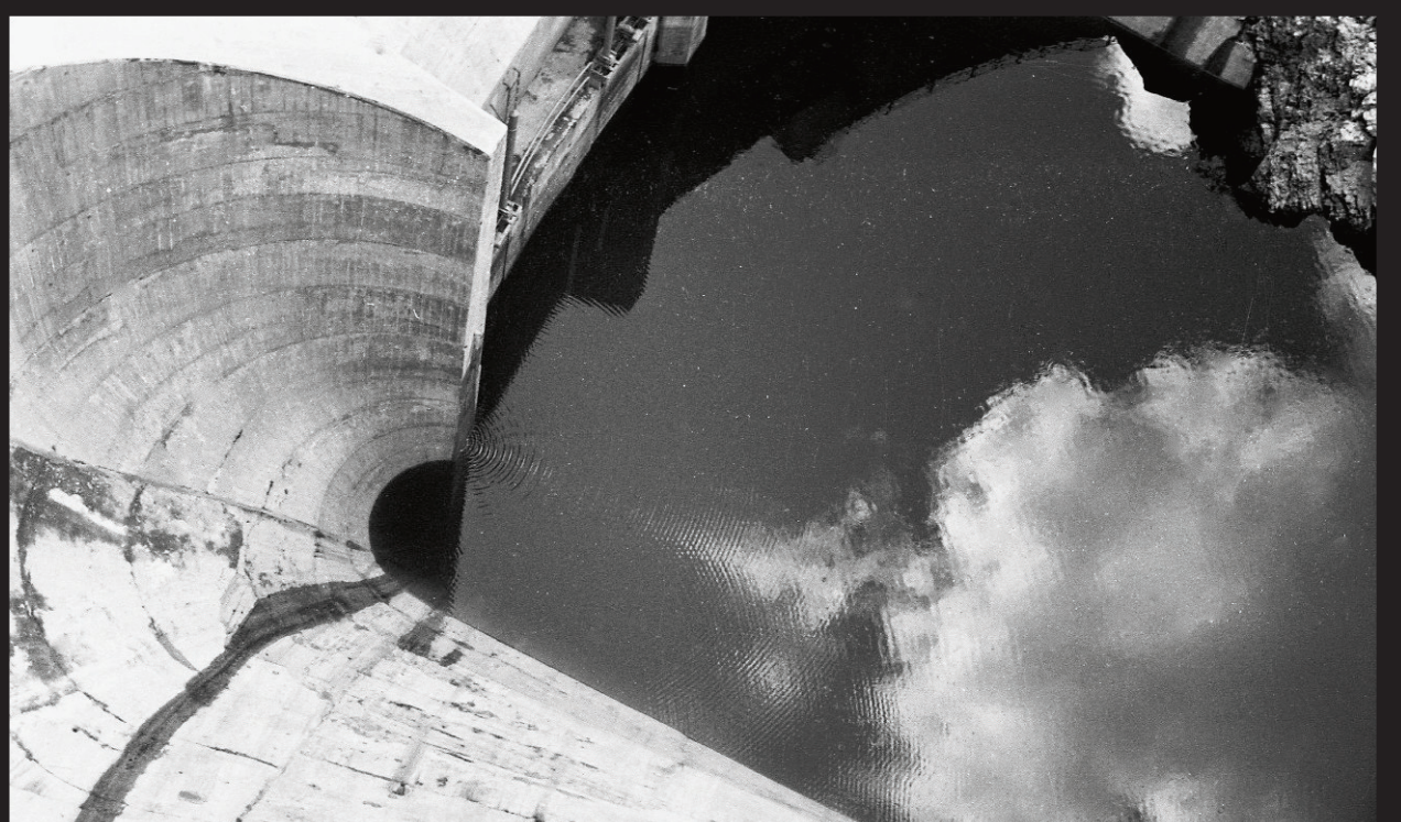
AU FIL DE L'EAU Le barrage du Châtelot constitue l'un des ouvrages spectaculaires du canton en matière d'exploitation d'énergie hydraulique. Rarement vu sous un angle si acrobatique, il a été mis en service à l'automne 1953 et aussitôt photographié par Fernand Perret. /cg/DAV-BVCF (FONDS FERNAND PERRET)
