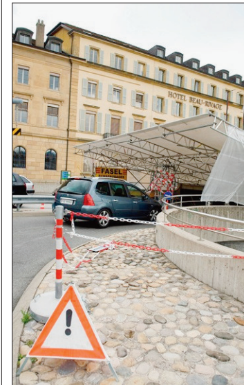
RÉNOVATIONS Les rampes d'accès sont remises à neuf. (DAVID MARCHON)
