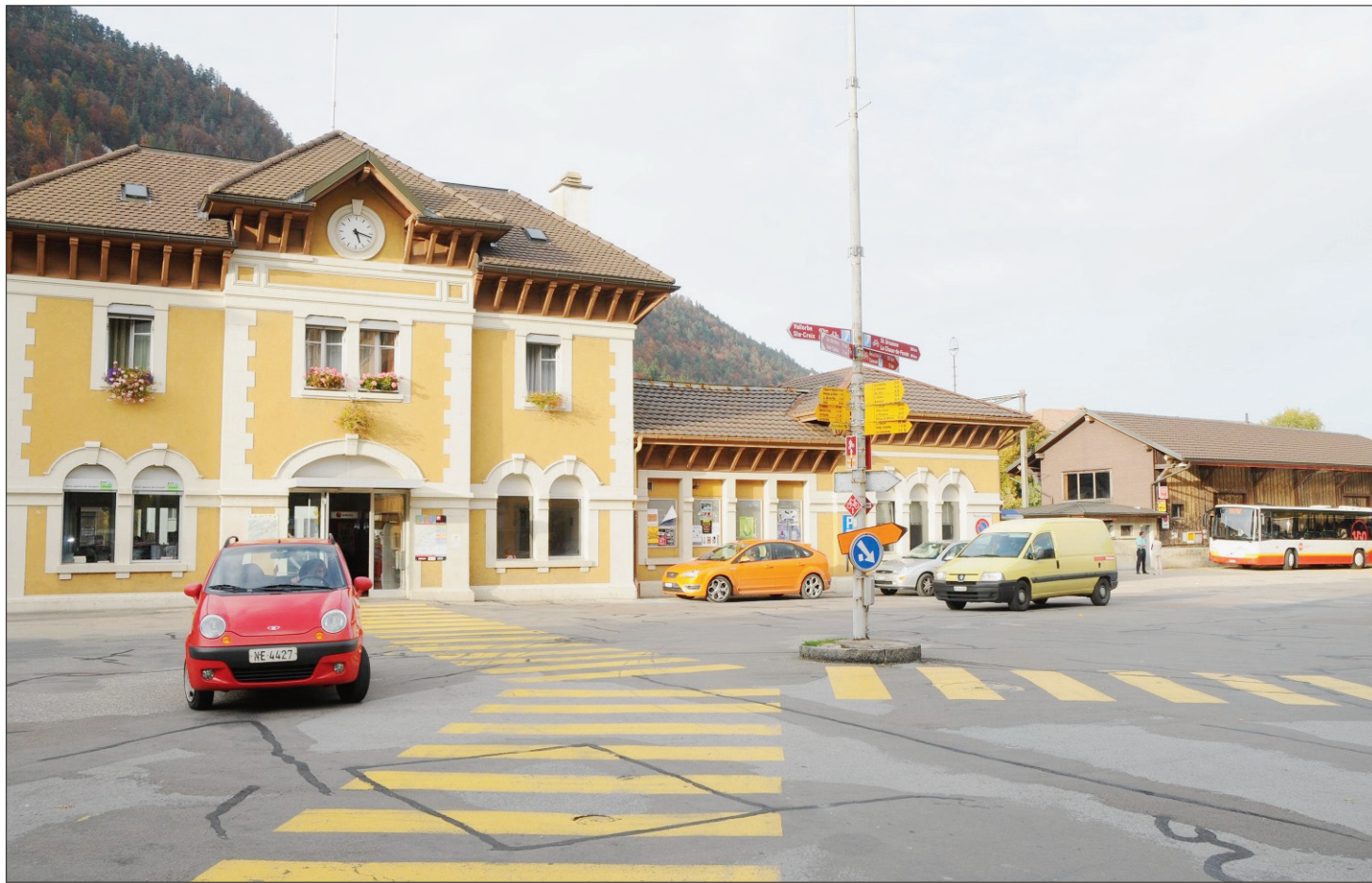
LIFTING La gare et sa place seront entièrement repensées. Une gare routière verra également le jour.
