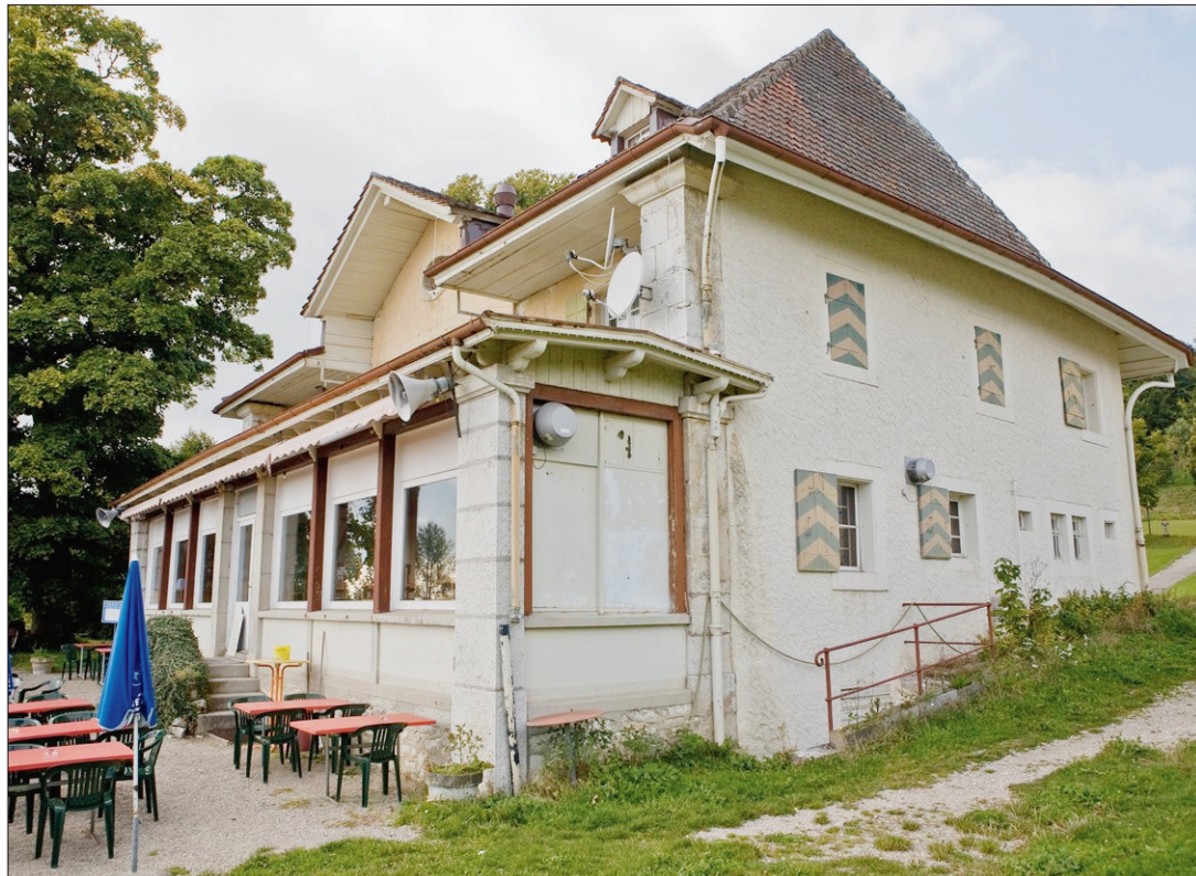
LE PETIT-HÔTEL Les travaux d'assainissement et de rénovation sont estimés à 1,4 million de francs.
