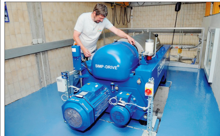
CENTRIFUGEUSE Jean-Paul Bürki pose devant la nouvelle installation, encore en rodage, de la step du Rafour de Saint-Aubin. (DAVID MARCHON)
