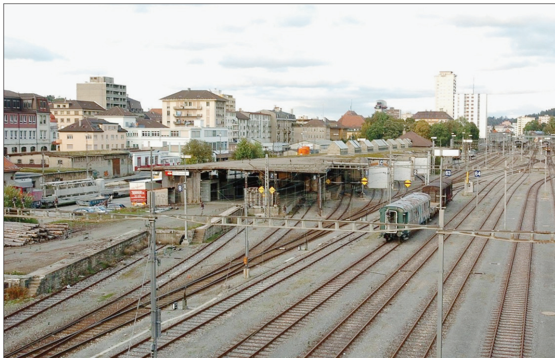
FRICHE CFF Au sud des voies, d'Entilles-Centre à la gare, 50 000 mètres carrés à transformer en un nouveau quartier déjà baptisé Le Corbusier. (ARCHIVES RICHARD LEUENBERGER)
