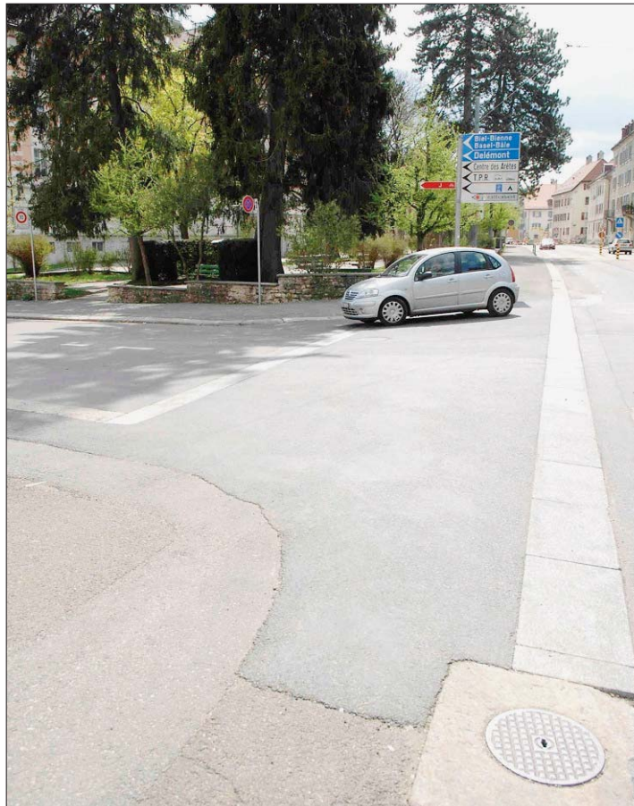
CHARRIÈRE Un des trottoirs continus réalisés l'année dernière coupe la rue du Marais à 30 km/h. Les piétons y ont la priorité. (DAVID MARCHON)
