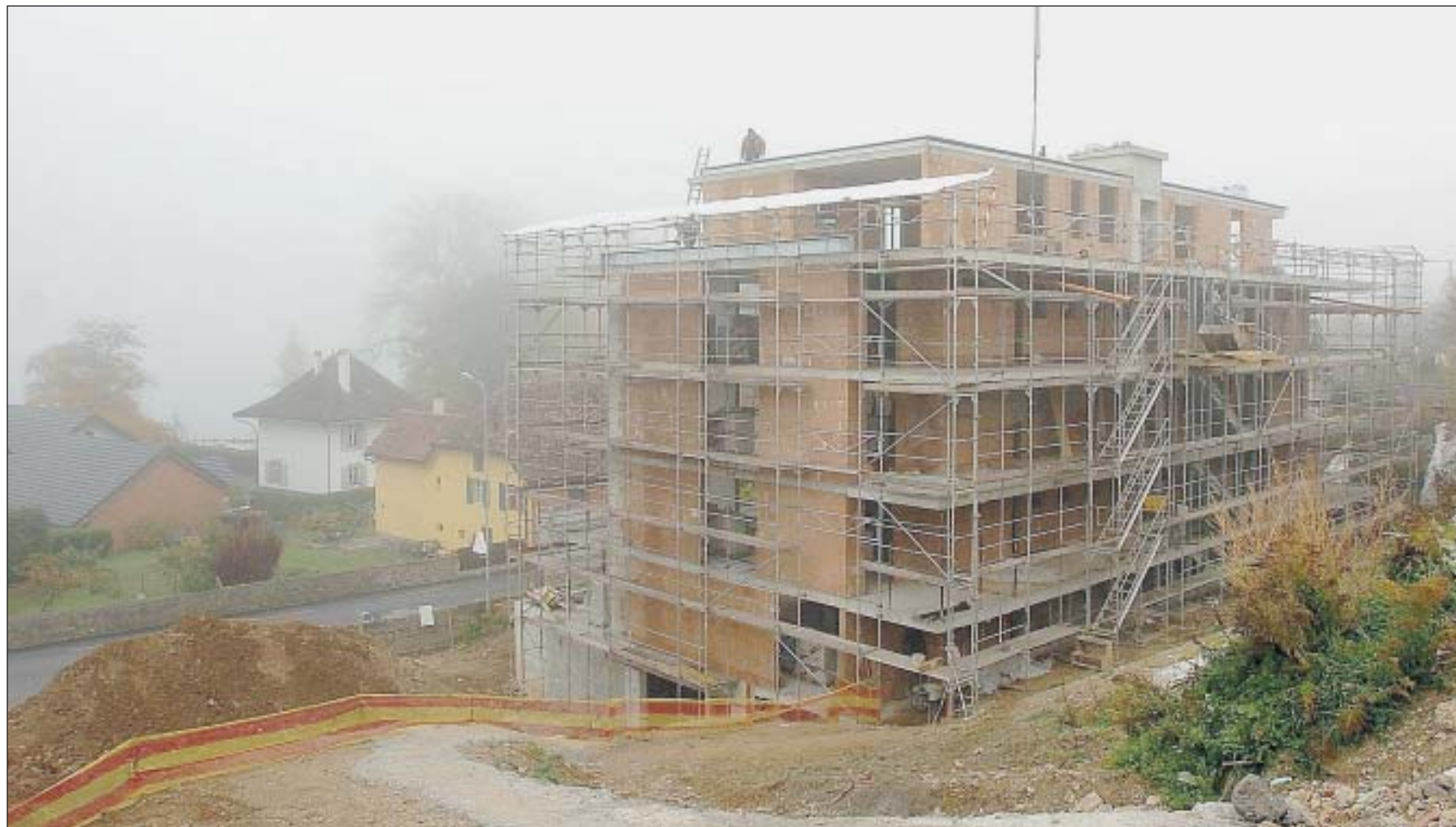
Le gros œuvre du nouvel immeuble écologique, qui fait face au lac, est terminé à l'Avenue du Littoral 3, à Chez-le-Bart. Les appartements et l'attique du dernier étage seront habités dans le courant de l'été 2007.
