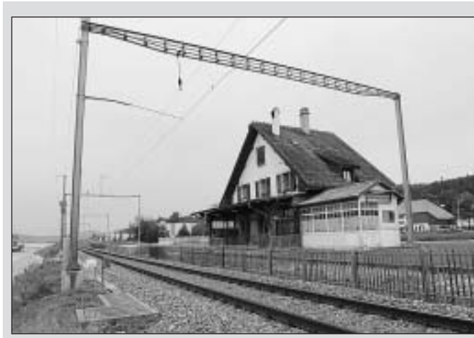
Un quai de 150 mètres devrait être aménagé à la halte ferroviaire du Crêt-du-Loche. PHOTO ARCH-GALLEY
