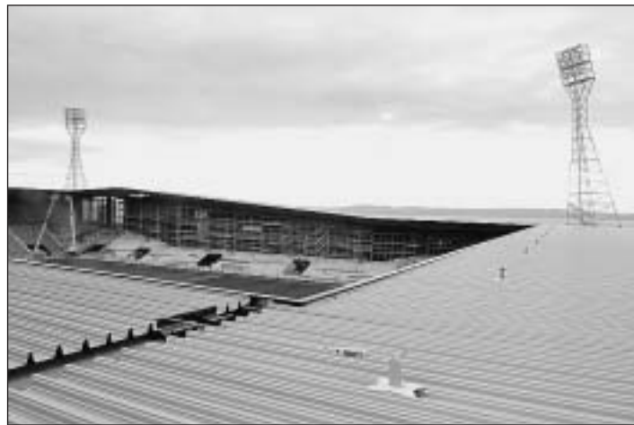
Actuellement, seul un tiers de la surface du toit est utilisé.
