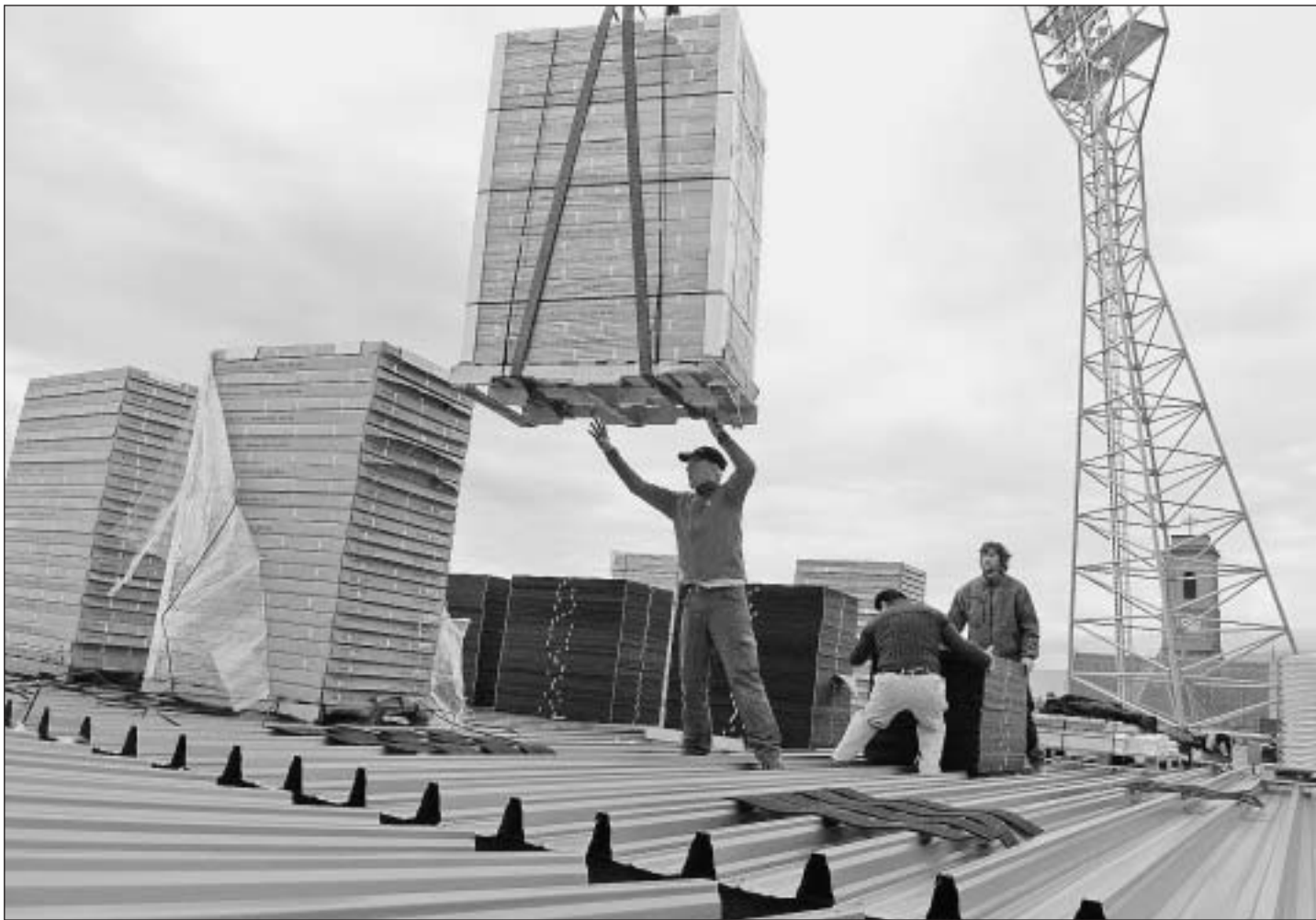
Les palettes contenant les panneaux solaires entourés de cartons ont été réceptionnées hier matin par huit personnes sur le toit du complexe de La Maladière. Cinq d'entre elles les installeront dès aujourd'hui.
