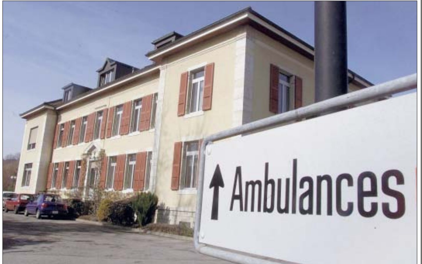
Les murs, le mobilier, l'équipement, les stocks ainsi que le terrain ont été vendus à l'Hôpital neuchâtelois. L'acte de vente a été signé le 5 septembre et faisait suite à une convention d'intégration datant du 13 décembre 2005. PHOTO ARCH-MARCHON
