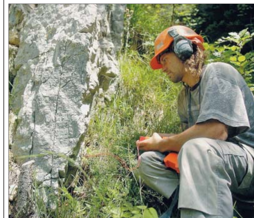
Julien Schoch, de l'entreprise spécialisée Acro Bât, a glissé en sept points deux kilos d'explosifs dans le rocher. Abris plus loin, il est prêt à le faire sauter.
