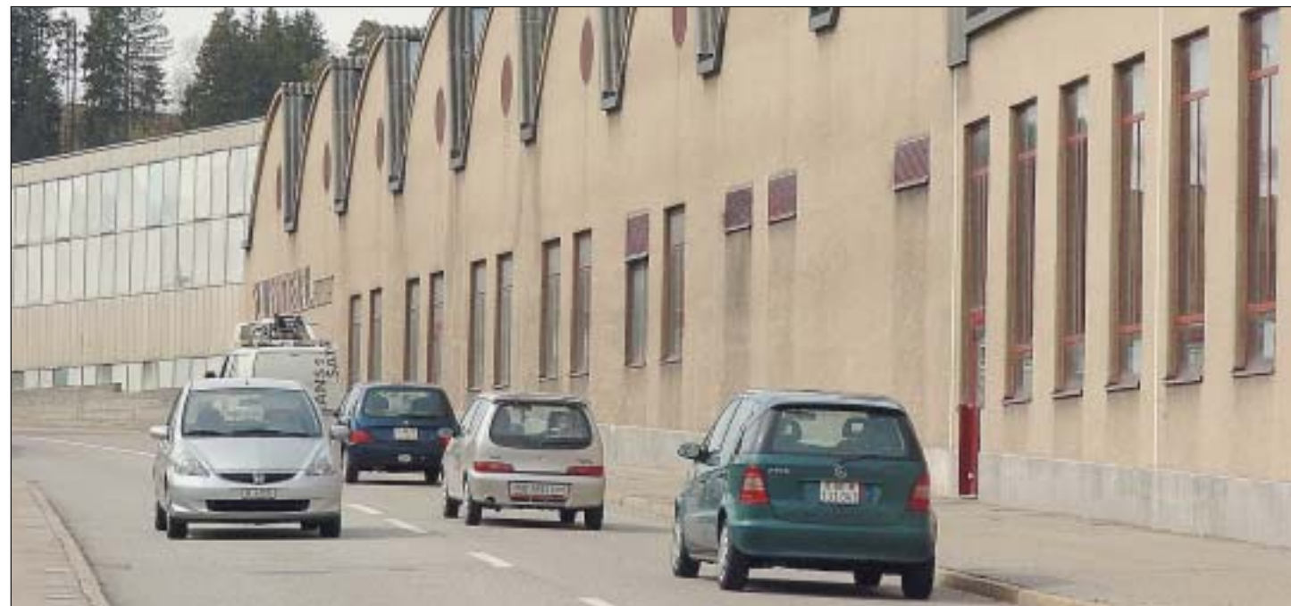
Depuis lundi, la Boillat, à Reconvilier, est officiellement en vacances. C'est le moment qu'a choisi la direction pour déplacer des machines. Un long processus de démantèlement semble amorcé. PHOTO LEUENBERGER
