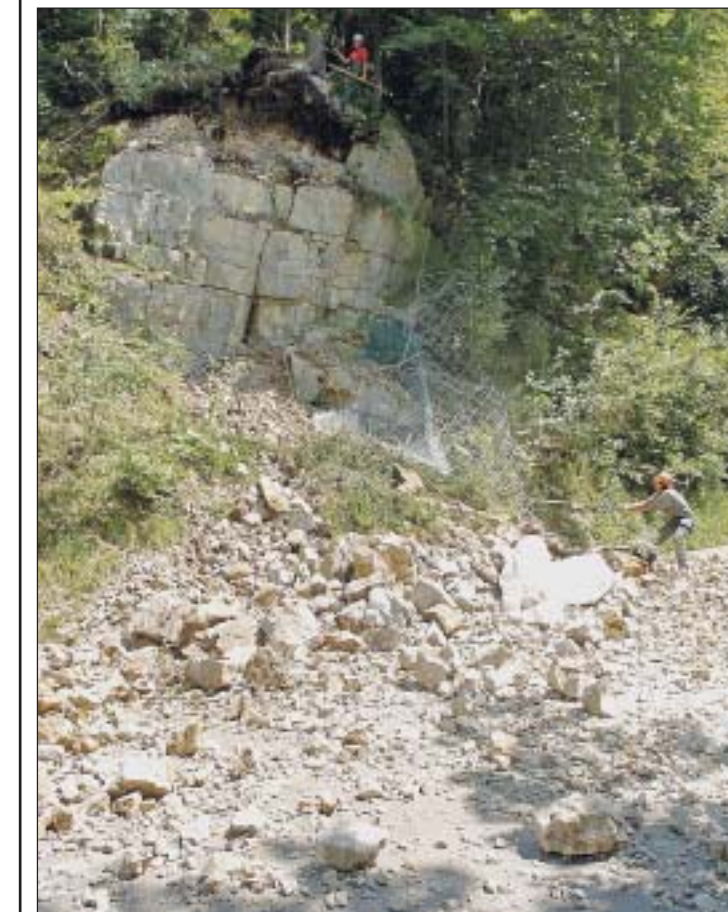
Après l'explosion, deux acrobates finissent de purger le rocher. PHOTOS MARCHON
