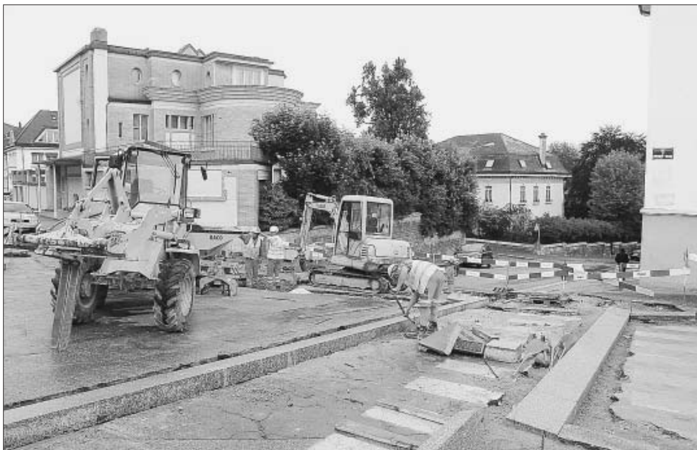
A l'intersection des rues de la Fusion et de Président-Wilson, des trottoirs en continu sont en construction pour indiquer physiquement que l'on entre dans une zone à 30 km/heure. Elles seront toutes bordées ainsi. PHOTO LEUENBERGER
