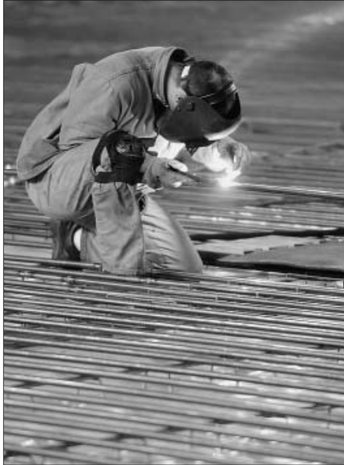
La soudure dans les coudes doit être d'une extrême précision pour éviter tout risque de fuite. PHOTO GALLEY
