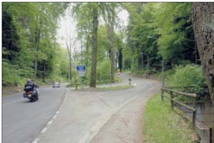
La pose du tapis de bitume définitif est agendée en début de semaine prochaine sur l'axe Bôle-Rochefort (ici le carrefour de Chambrelieu). PHOTO GALLEY
