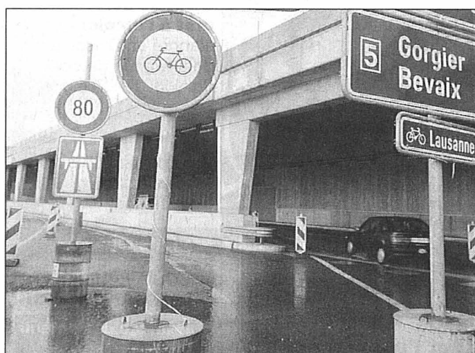
Les tunnels sous la Béroche resteront encore en travaux pendant un mois environ. PHOTO MARCHON
