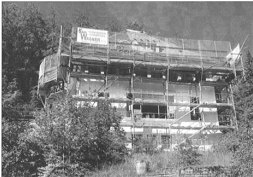
A la Maison blanche, chemin de Pouillier 12, les travaux de restauration de la villa datant de 1912 vont bon train.
