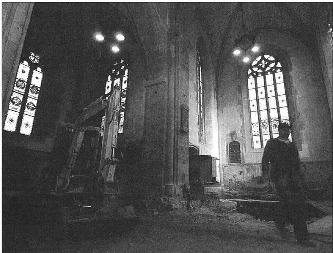
L'intérieur de la nef est méconnaissable.
