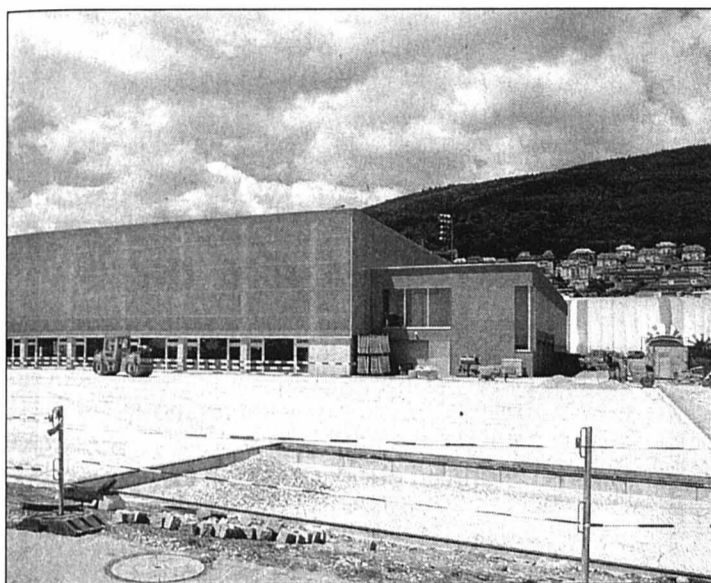
Ici vue du sud, la place est aménagée entre la halle secondaire des patinoires, la station d'épuration et le chemin goudronné qui longe le lac.
