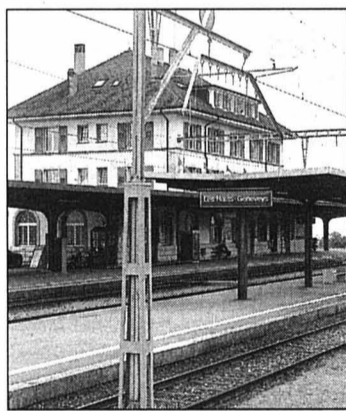
La gare des Hauts-Geneveys aura un tout nouveau sous-voie. PHOTO ARCH
