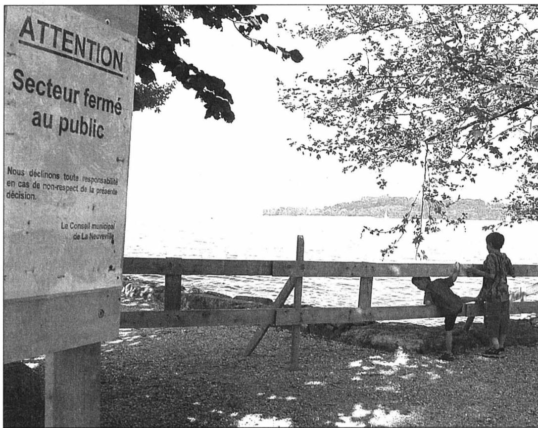
Le glissement de terrain sur les rives de Saint-Joux s'avère plus problématique que prévu. Une section d'environ 50 mètres restera fermée quelques temps encore. PHOTO TEROL
