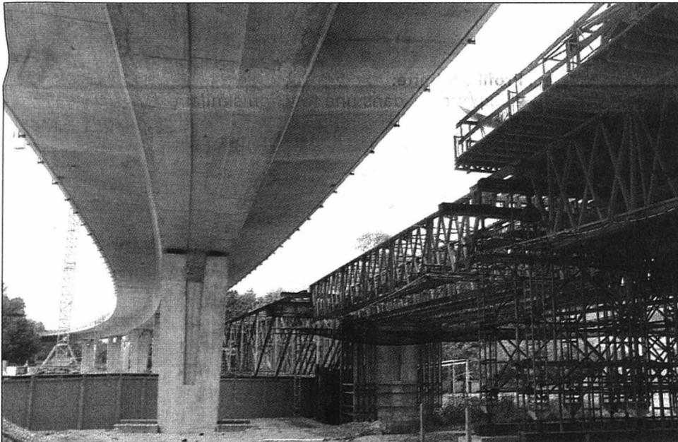
Deux ponts constitueront le viaduc de Chané-laz, à l'est de Boudry. Presque terminées, les voies descendantes (longueur 535 mètres), doivent encore recevoir des parois antibruit en verre, une étanchéité et le revêtement routier. Les cintres oranges permettent de deviner l'ouvrage qui accueillera les voies montantes (599 mètres). Une galerie technique, aménagée dans le caisson du pont sud, courra sur toute la longueur du viaduc.
