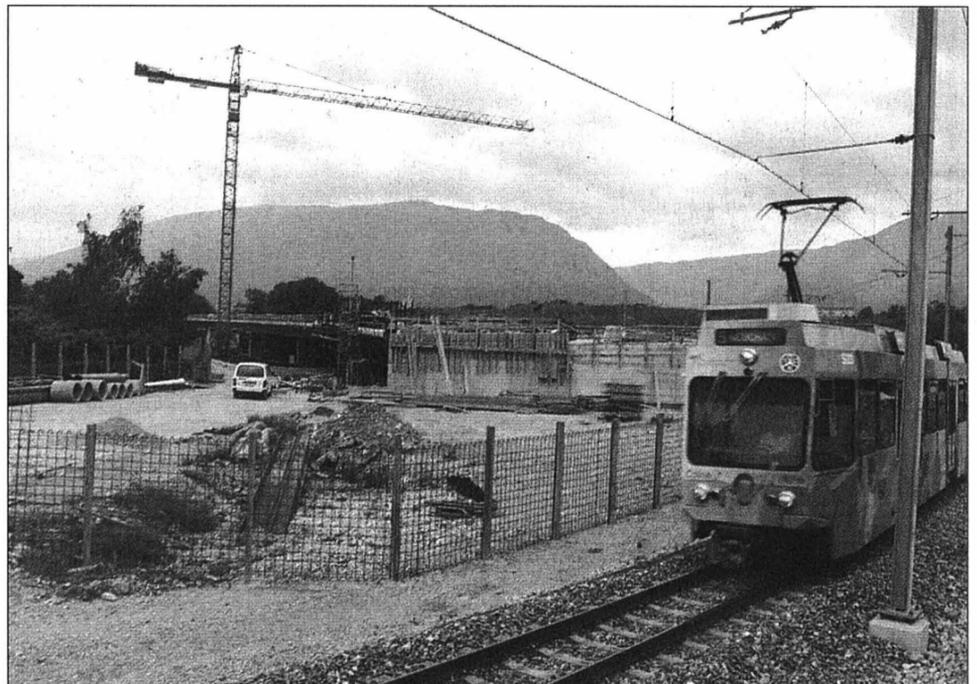
A Areuse, la voie du Littorail sera définitivement déplacée cet automne dans sa partie ouest. Elle passera au sud de la culée (extrémité du pont), puis s'engouffrera sous le viaduc pour retrouver la voie existante au nord de l'Areuse. Le tracé autoroutier sera alors complété.
