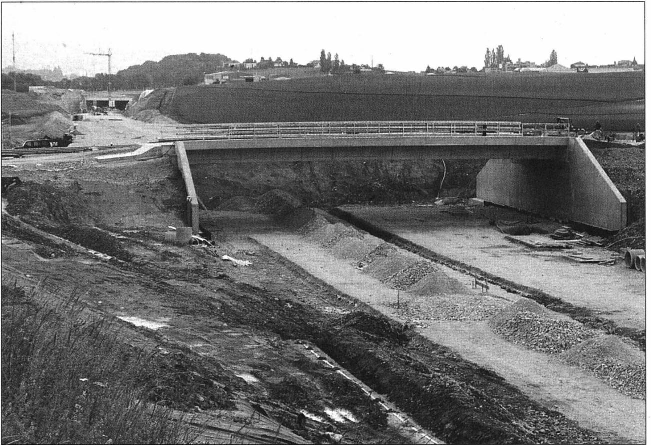
Le passage supérieur qui enjambe la tranchée autoroutière entre Bevaix et Boudry sera ouvert à la fin du mois de juin. Sa mise en fonction permettra de désaffecter la déviation actuelle en direction de Cortaillod. Au fond, on distingue les deux tubes de la tranchée couverte de Chané-laz. La colline étant instable, des mesures sont régulièrement effectuées à l'aide d'inclinomètres.
