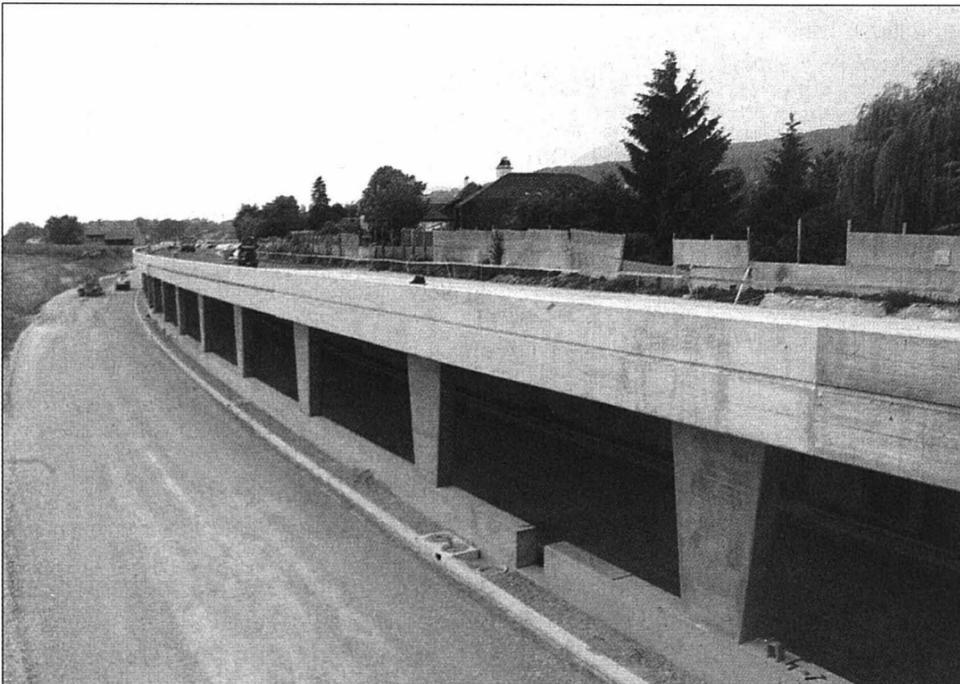
Sur l'ancien tracé de contournement de Bevaix, le bétonnage de la tranchée semi-couverte est terminé (seule la voie nord est couverte). La chaussée est en cours de construction. La route cantonale, qui doit traverser la localité, a déjà subi d'importantes améliorations.
