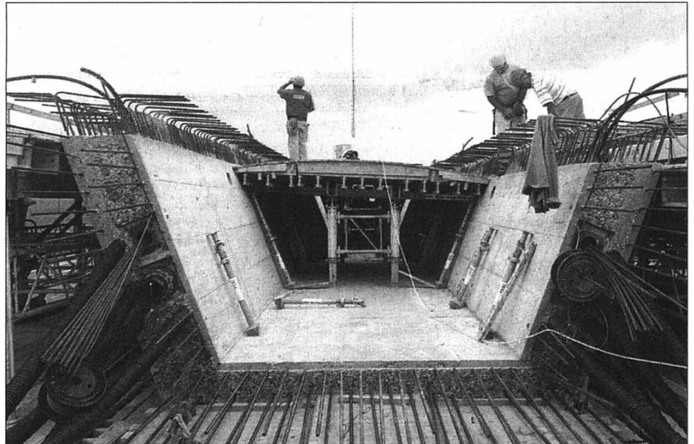
La construction du caisson du pont nord, comme celle du tablier (dalle de roulement) avance par étapes de 50 mètres. Sur le «V» en béton, on distingue le montage du coffrage du tablier. Les câbles, à droite et à gauche, servent de précontrainte à l'ouvrage. Monté en partie sur des appuis glissants, le pont peut absorber une dilatation allant jusqu'à 30 centimètres de part et d'autre.
