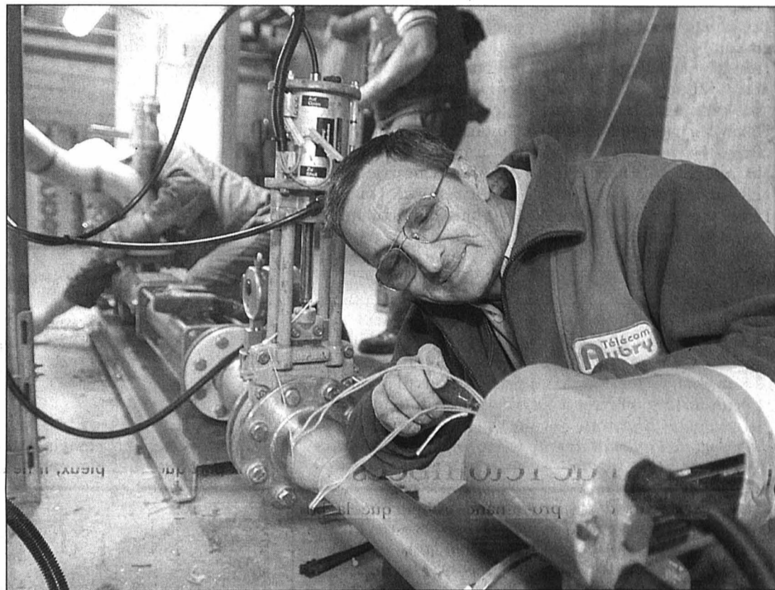
Les entreprises d'installation électrique du canton (ici, le chantier de la step de La Chaux-de-Fonds) sont pour la plupart de petite taille. PHOTO GALLEY
