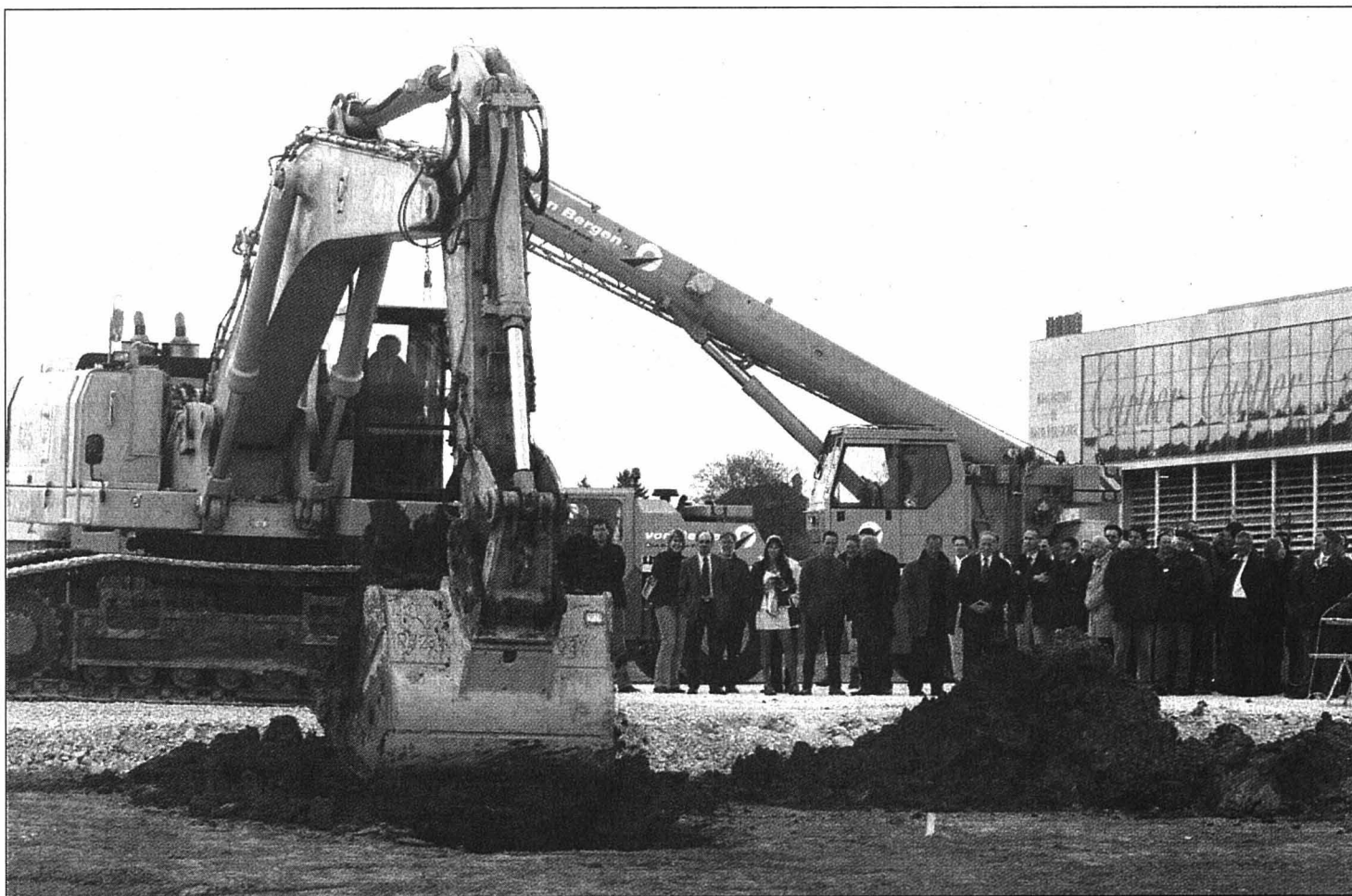
Le premier coup de pelle officiel est revenu au conseiller d'Etat Pierre Hirschy, le second à Charles Augsburgger (photo), président de La Chaux-de-Fonds. Les travaux devraient durer jusqu'en 2007. PHOTO MARCHON
