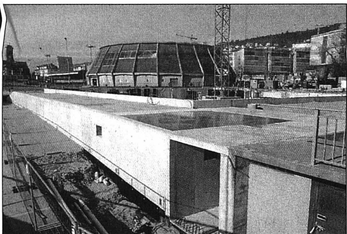
La halle omnisports de la Riveraine (en construction au premier plan) sera achevée avant que ne soit démolie la halle omnisports de la Maladière (au second plan). PHOTO ARCH GALLEY
