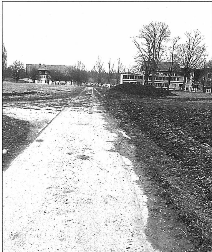
Au premier plan, le site retenu pour la construction d'une chambre pour les eaux de pluie, en amont des bâtiments de Landeyeux. PHOTO CHOPARD
