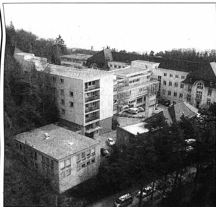
Il s'agira d'abord de dire si des bâtiments doivent être conservés pour des raisons patrimoniales.
