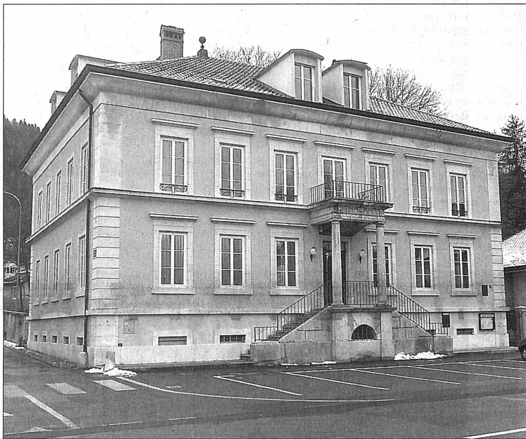
Les douze millions de fortune communale, dont fait partie l'Hôtel de ville, suffiront sans devoir augmenter le coefficient fiscal. PHOTO DE CRISTOFANO
