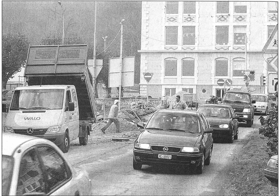
Les travaux sous la route cantonale qui ont perturbé la circulation depuis le mois de septembre seront terminés à la fin de la semaine.
