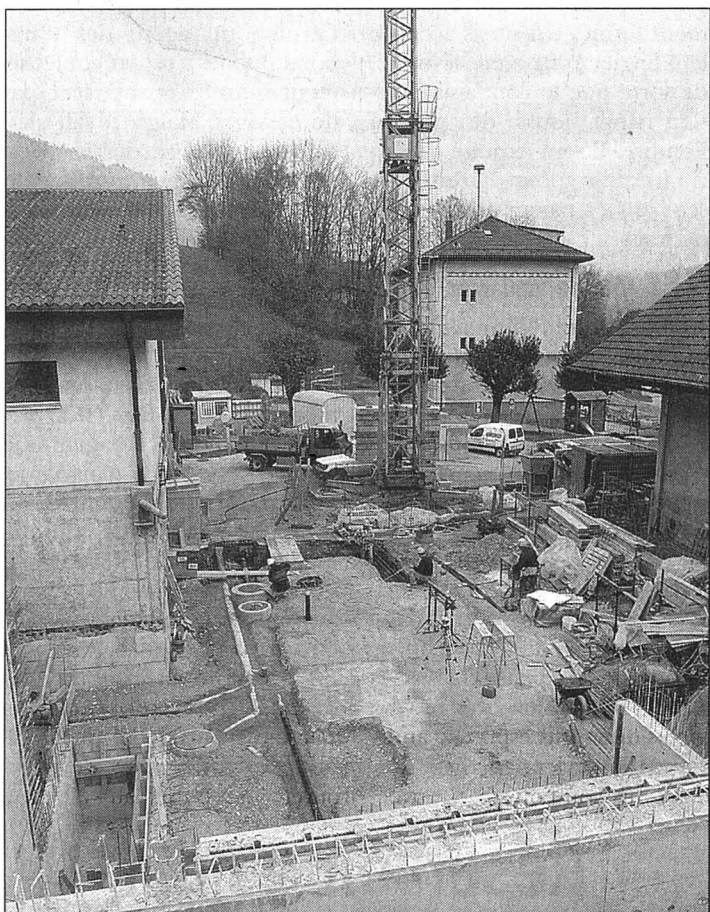
Le nouveau bâtiment du chauffage abritera également un local annexe destiné aux travaux publics.
