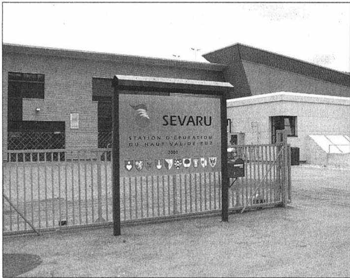
La toute moderne station d'épuration de La Rincieure.
