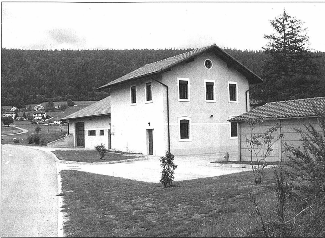
Le pompage de l'eau potable, aux Prés-Royer (photo) et à la station d'épuration de La Rincieure, emploie déjà le même personnel d'exploitation.
