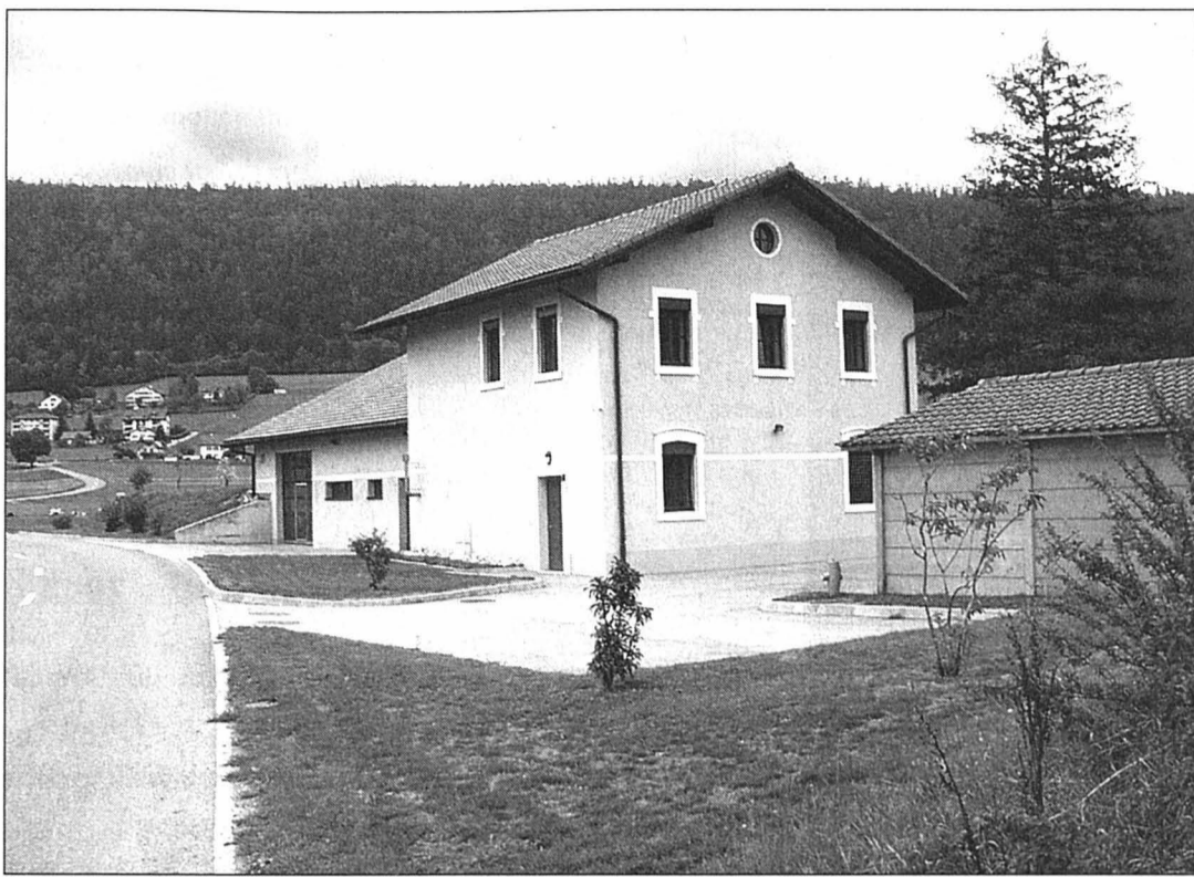
Le pompage de l'eau potable, aux Prés-Royer (photo) et à la station d'épuration de La Rincieure, emploie déjà le même personnel d'exploitation.
