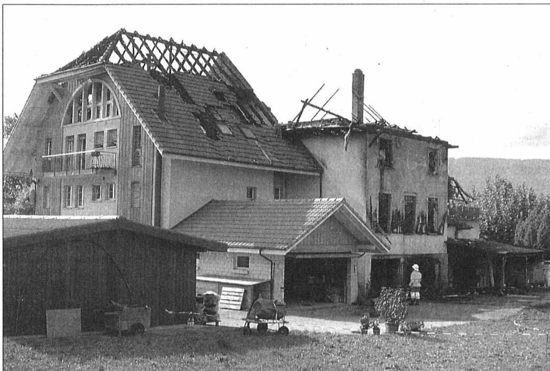
Seuls quelques pompiers veillaient encore, hier après-midi. Mais, tôt le matin, 95 d'entre eux ont été dépêchés sur place. PHOTO TEROL
