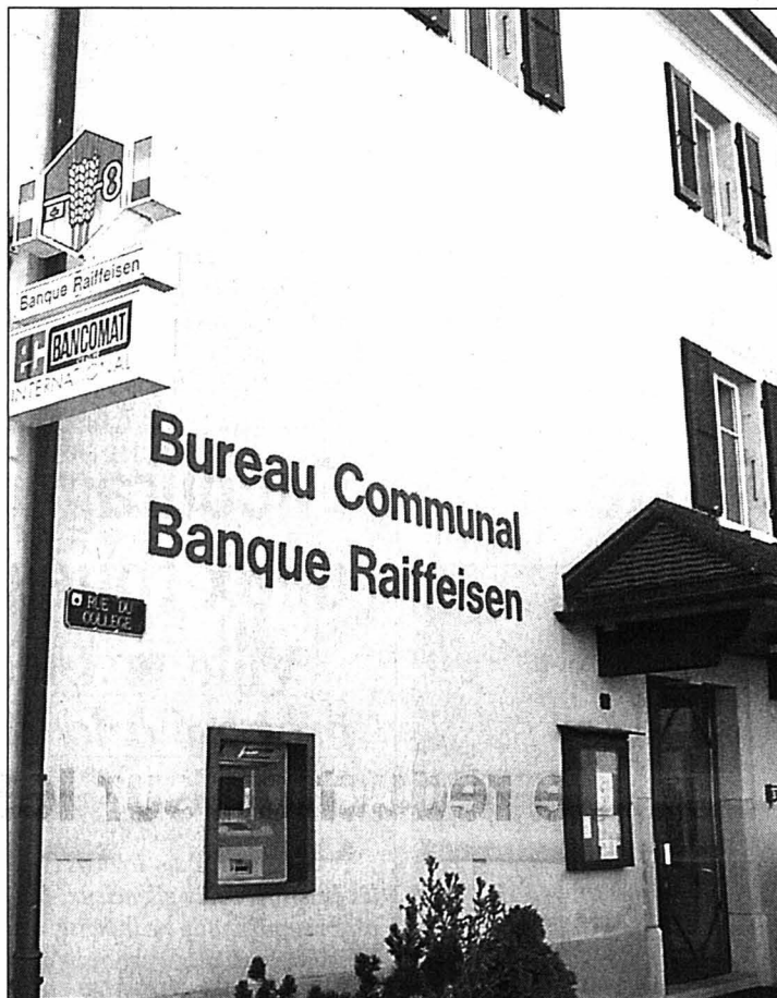
Les locaux du rez-de-chaussée de cet immeuble, occupés par la banque Raiffeisen, ne répondent plus vraiment aux besoins de leur locataire. PHOTO ARCH-LEUENBERGER
