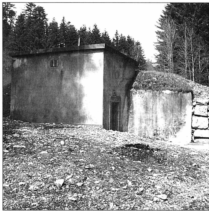
Le réservoir de Montmollin pourra être géré à distance et en commun par les trois villages de l'ouest du Val-de-Ruz, si ceux-ci rallient un système piloté depuis Neuchâtel.
