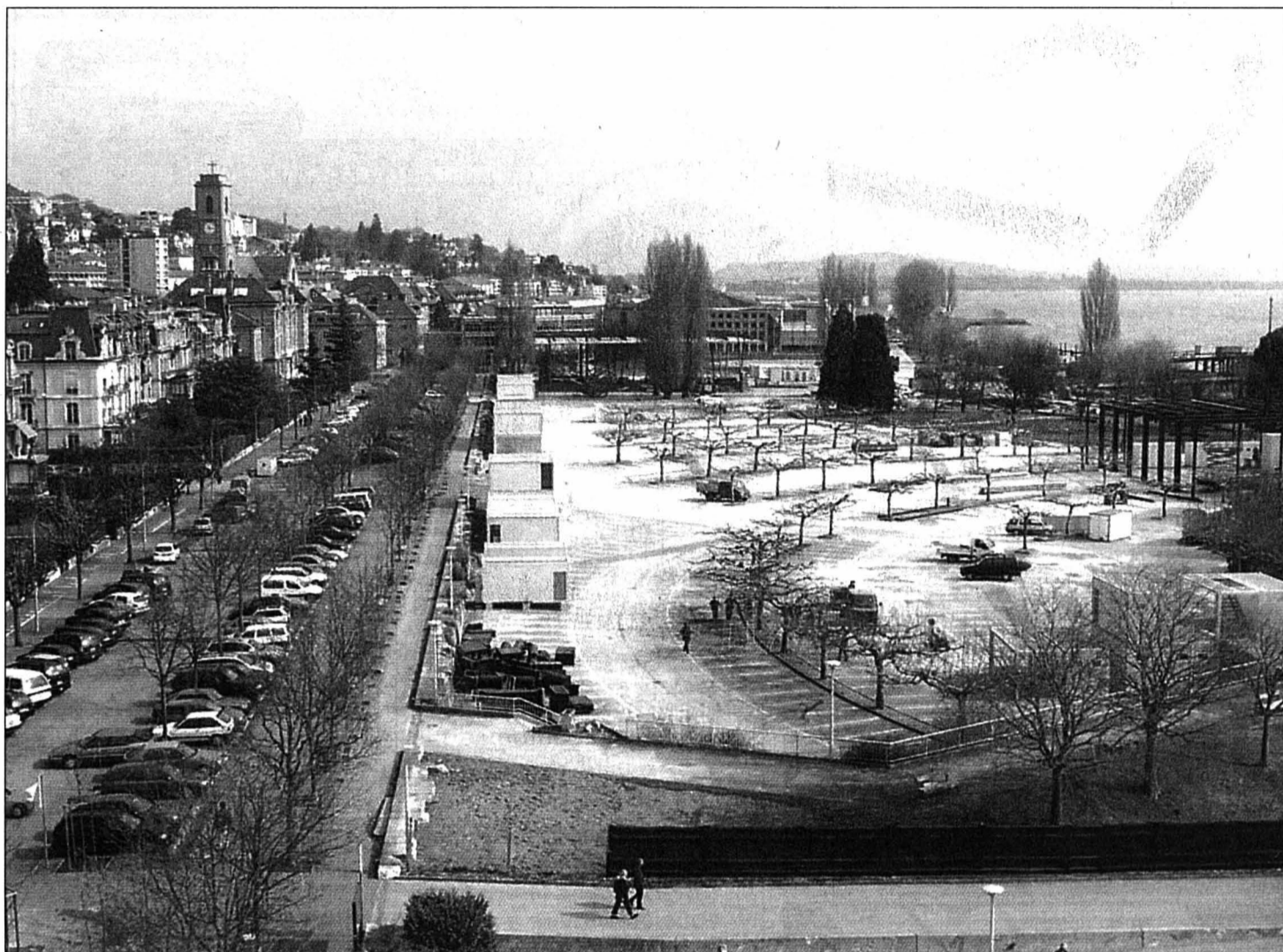
La situation actuelle des Jeunes-Rives en chantier de déconstruction.
