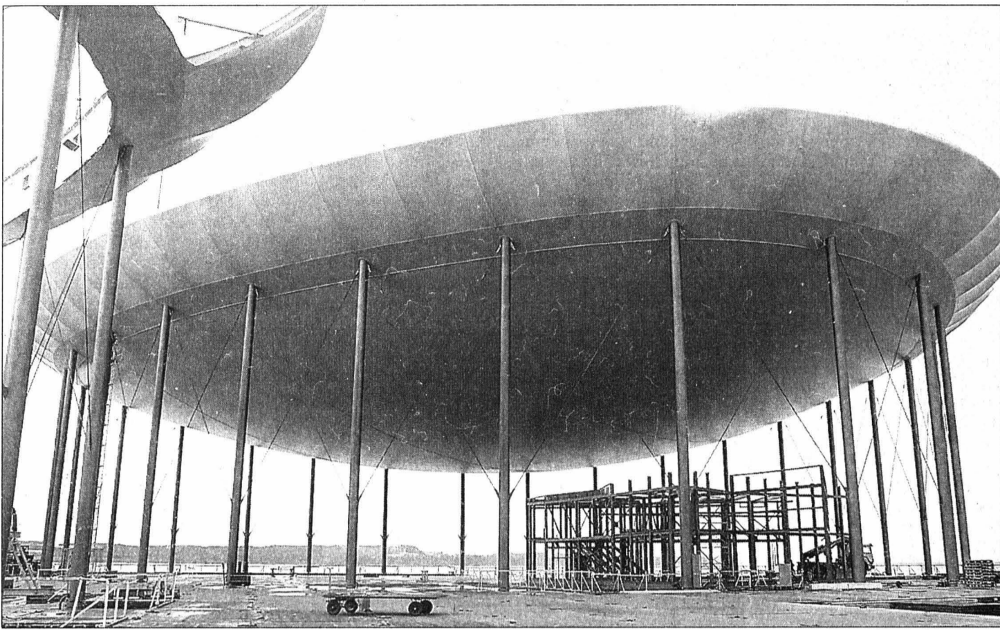
Actuellement, le pavillon métallique est en phase de démontage sur le défunt arteplage.
