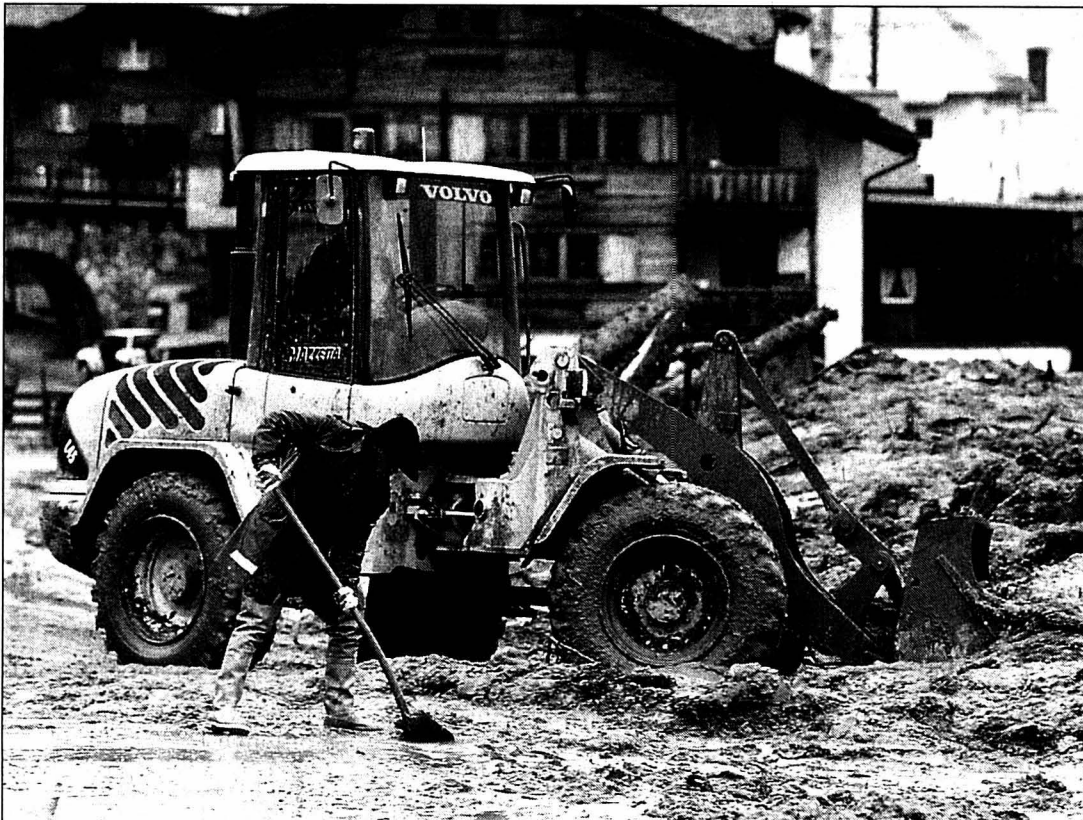
Opérations de déblaiement dans le village grison de Trun. PHOTO KEYSTONE
