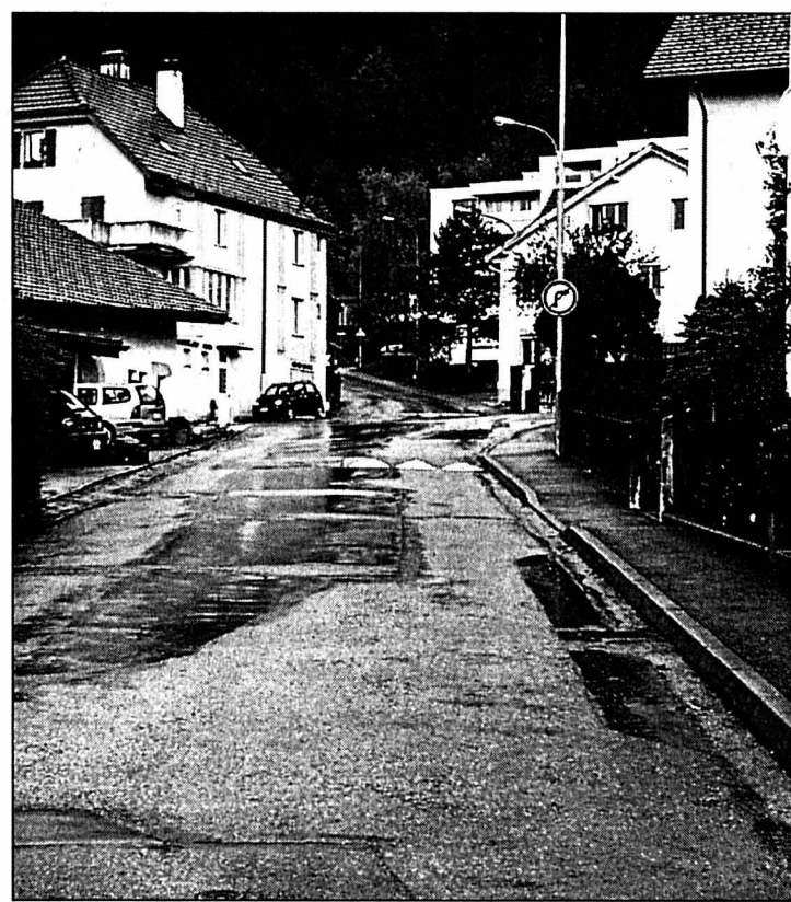
Le Crêt-Debély et la rue du Stand vont bientôt être auscultés en profondeur pour envisager l'aménagement du système séparatif.
