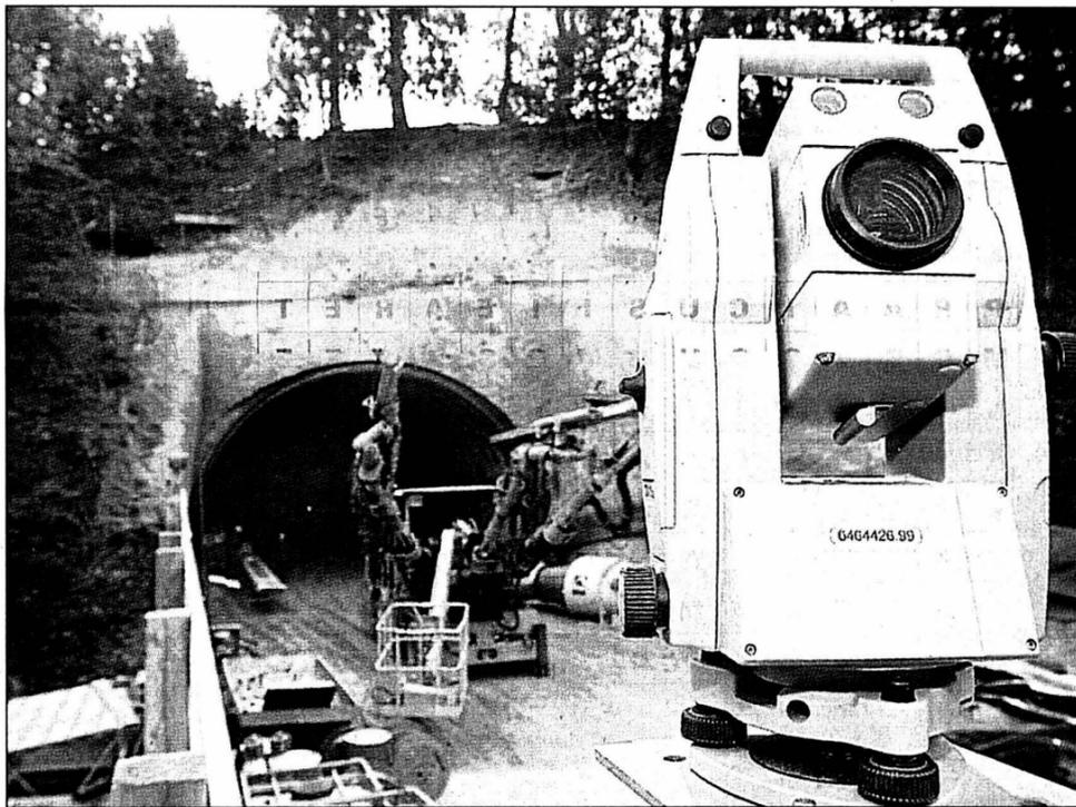
Le théodolite automatique, une des pièces maîtresses du système de guidage automatique.
