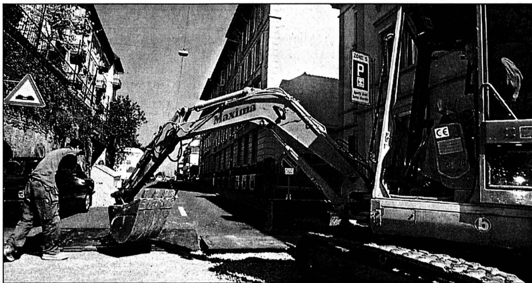
Les anciens gendarmes couchés feront place à des ralentisseurs de trafic conformes aux normes actuelles. PHOTO MARCHON
