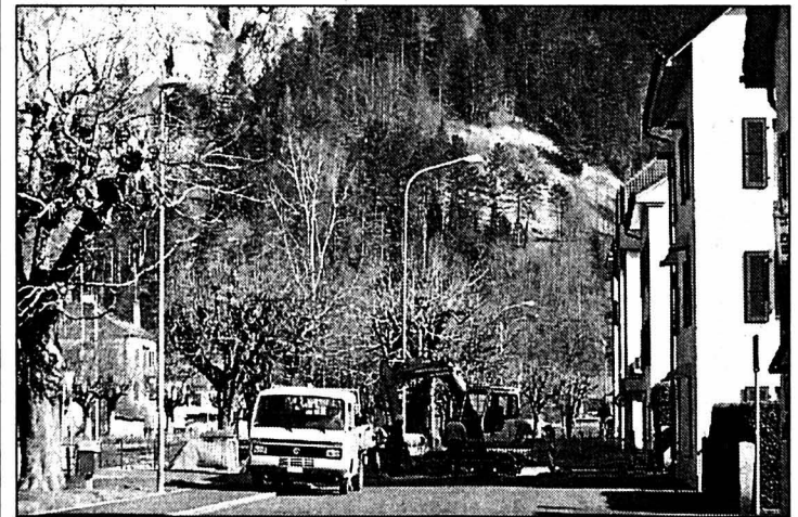
La deuxième étape de réfection débute. PHOTO DE CRISTOFANO
