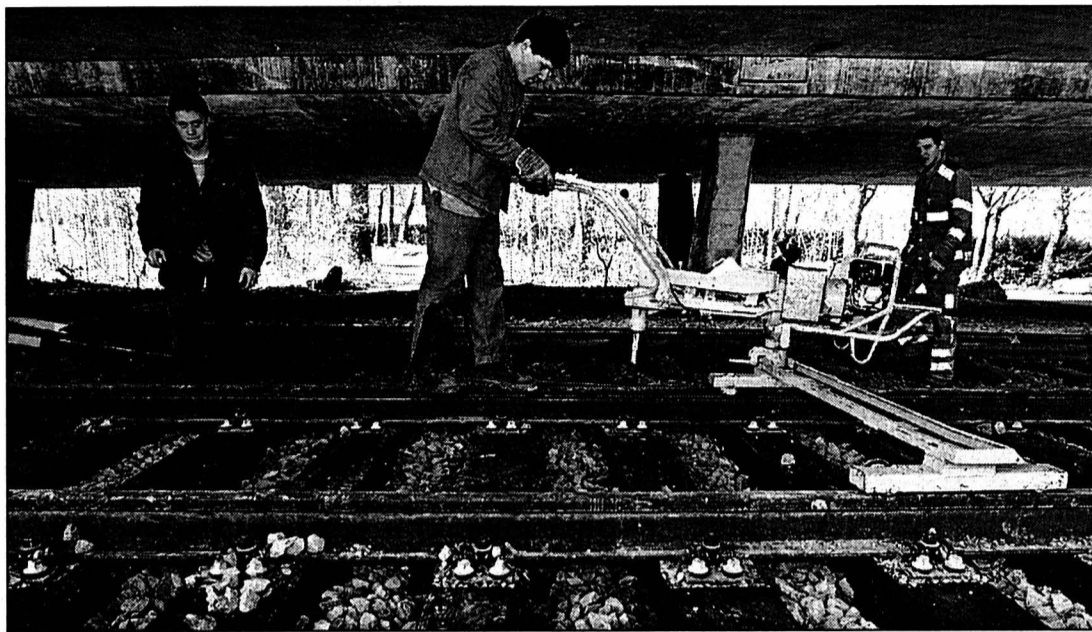
Les jeunes apprentis construisent, en site scolaire, une double voie type CFF sous l'autoroute A5.
