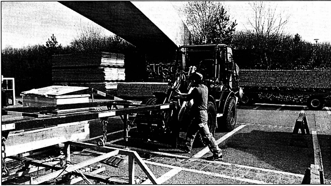
Déchargement des lames de bois qui composeront les chemins du village de tipis.
