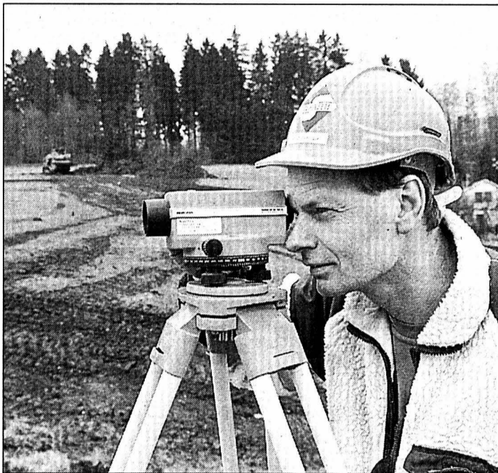
L'usine en construction, à la Combeta, sera terminée au printemps 2003. PHOTO LEUENBERGER
