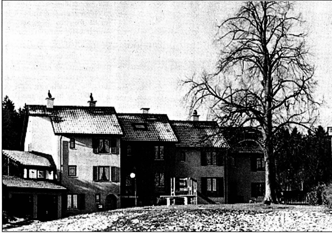
L'expert examine l'état d'entretien global de l'immeuble.
