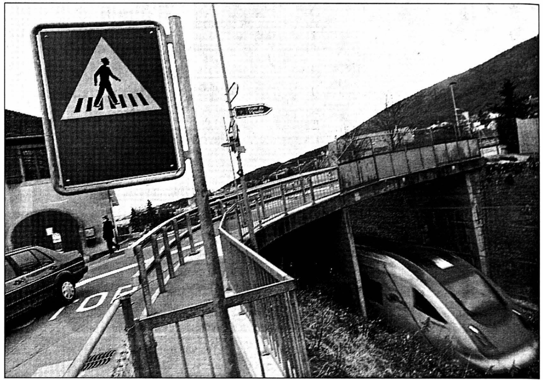
Le Conseil communal de Saint-Blaise entend profiter des chantiers menés par les CFF pour réaliser des travaux à moindre coût. PHOTO MARCHON
