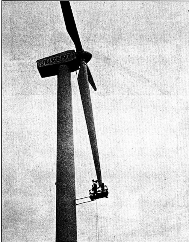
Réparation d'une éolienne abîmée par la foudre à Mont-Crosin. PHOTO A-KEYSTONE
