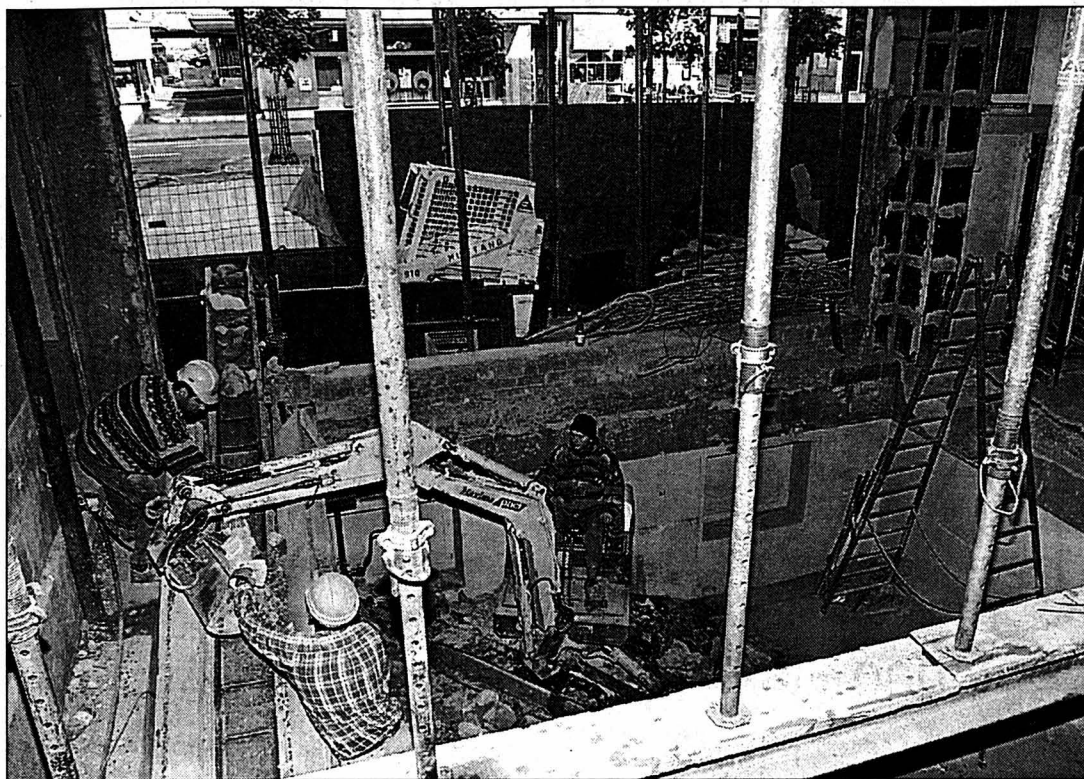
A cet emplacement se trouvera la future cage d'escalier et l'ascenseur qui desserviront le théâtre et la salle de musique.
