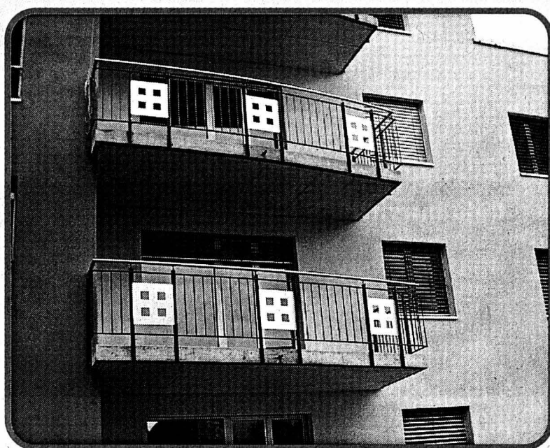
Rue des Fahys 93, balustrades contemporaines personnalisées. Réalisation Serrurerie Nouvelle. / Ica-E
